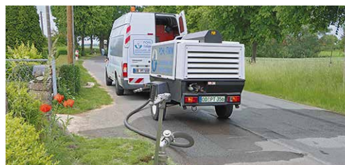
So sieht es aus, wenn die Spülung im Gange ist: Links das erste Spülwasser, rechts das Ergebnis hinterher. Der Kompressor in der Mitte „schießt“ das Luft-Wasser-Gemisch durch die Rohre. Fotos: SPREE-PR/Archiv
