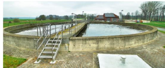
Wie hier auf der Kläranlage Dobbertin werden in ganz MV Anlagen zur Phosphoreliminierung nachgerüstet. Der WAZV hat früh selbst Initiative ergriffen und will mit seinem Konzept die Einleitfracht um jährlich 1.000 kg mindern.
