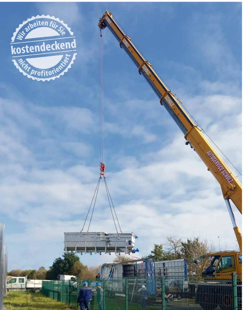
Anfang September kam die neue Rechenanlage an. Ein Schwerlastkran schwenkte sie auf das Gelände. Für den Einbau war die Rechenanlage zwei Tage außer Betrieb. In der Zeit wurde das Abwasser in den silbernen Tanks, den Pufferspeichern, aufgefangen.
