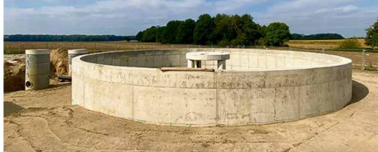
Das Nachklärbecken ist fertig. Es hat einen Durchmesser von 13 Metern, ist 4,5 Meter tief und fasst rund 550 Kubimeter Abwasser.
