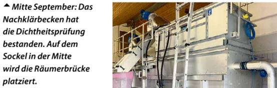
Mitte September: Das Nachklärbecken hat die Dichtheitsprüfung bestanden. Auf dem Sockel in der Mitte wird die Räumerrücke platziert.
