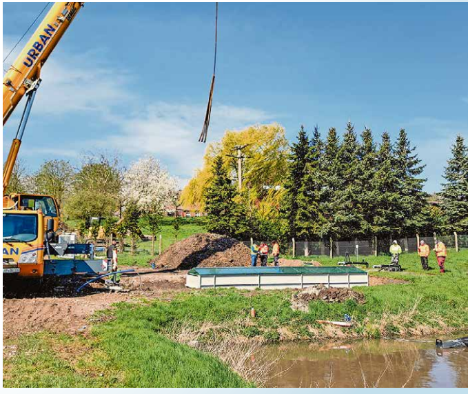
Mit einem Kran wurde die Scheibentauchanlage eingesetzt. Die sorgt nun für eine noch bessere biologische Reinigung.
