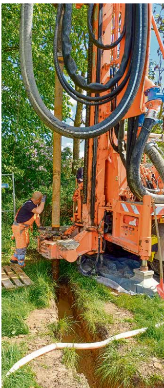
Ein Bild vom Bau der neuen Vorfeldmessstelle – inzwischen ist der gesetzlich vorgeschriebene Messpunkt fertig gebaut.
